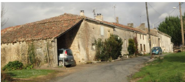
Appentis en moellon accolé à une succession de maisons rurales formant un ensemble remarquable (hameau du Groisard)
