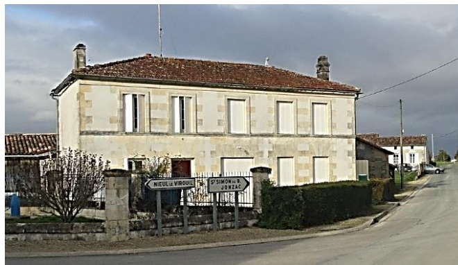
Maison de maître située dans le bourg. Maison à étage et à toiture munie de croupes latérales. Encadrements en pierres de taille.
