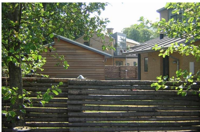
Barrières en bois naturel en limites séparatives
